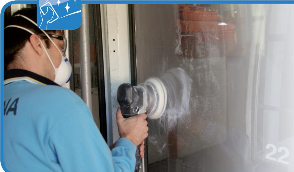
Pulido y abrillantado de plexiglás y policarbonato para la renovación de parabrisas de carrocería de cabinas.
